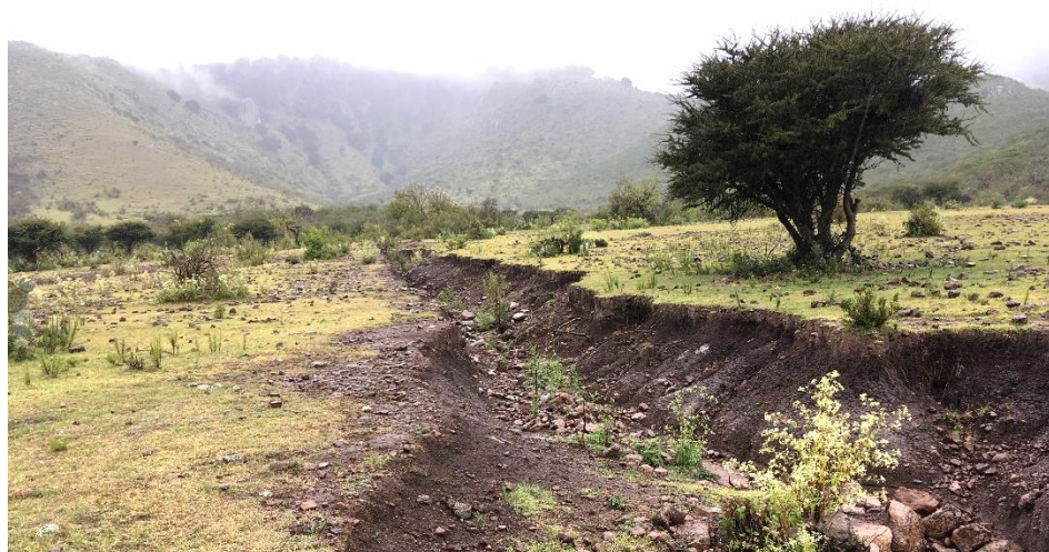
Fotografía 1. Parteaguas y zona media del polígono antes de la rehabilitación.
