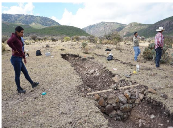
Rectificación de niveles de la presa filtrante
