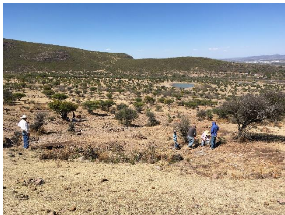
Área erosionada seleccionada para construcción de terrazas a curva de nivel
