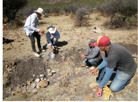
Nivelación de "hombros" de cárcava y trazo con cal
