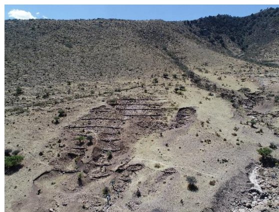
Detalle del sitio de construcción de terrazas a curva de nivel y presas filtrantes
