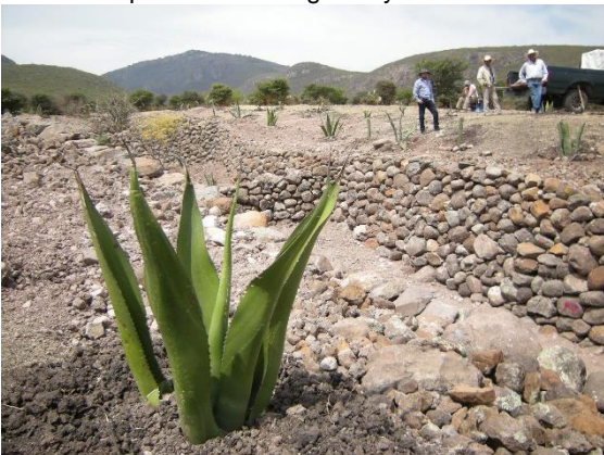
Agaves para retención de suelos en los "hombros" de la cárcava intervenida
