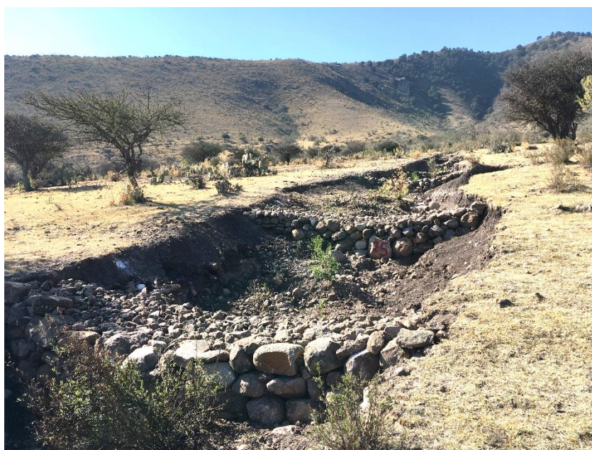
Fotografía 2. Presas filtrantes sistema “cabeza-pie”.
