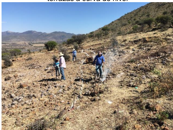
Delimitación de la terraza a construir con cal
