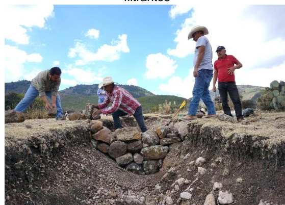
Construcción de presa filtrante demostrativa
