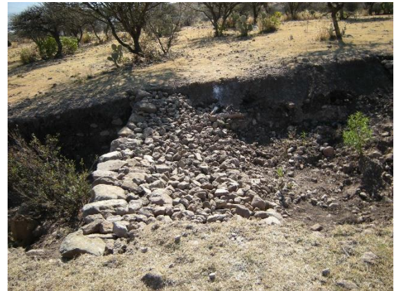
Vista lateral de la misma presa filtrante y el volumen construido hacia adentro "aguas arriba" para mayor estabilidad y funcionamiento.
