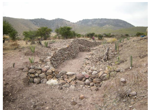
Panorámica de la cárcava intervenida con la rehabilitación plantación periférica e interior para estabilización de taludes
