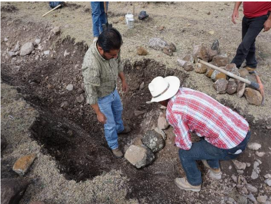
Excavaciones para empotramiento en taludes
