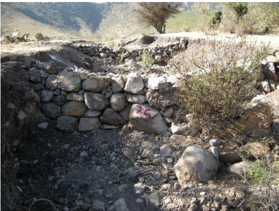
Serie de presas filtrantes construidas en canal convertido en cárcava. Nótese que el centro de la presa (vertedor) está por debajo del nivel de los "hombros" de la cárcava
