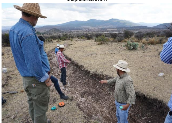
Uso del nivel de hilo en trazo de presas filtrantes
