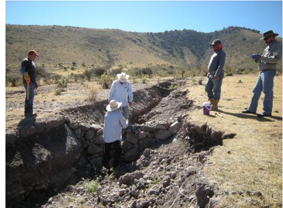
Cárcava con presas filtrantes de piedra acomodada
