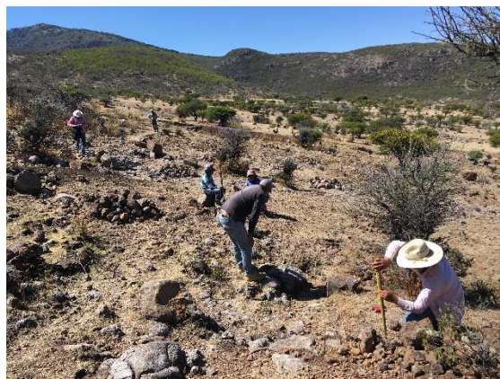
Trazo de curvas a nivel con nivel de hilo por el mismo grupo de trabajo capacitado
